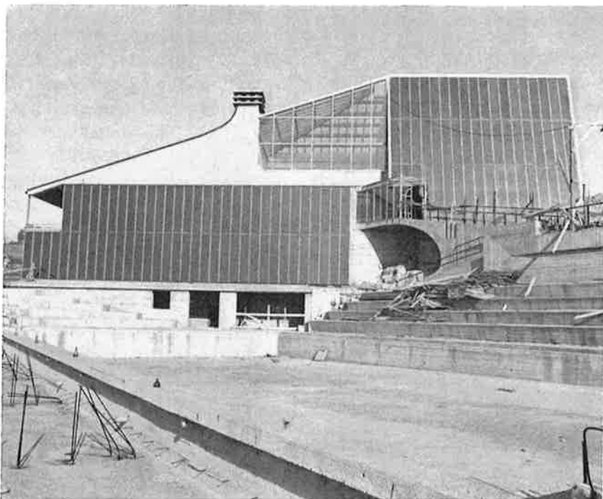
La nuova scuola materna a San Raffaele Alto, pronta per ricevere i bambini del Comune di San Raffaele Cimena, anche se l'area esterna non è ancora completamente sistemata: lo attestano gli attrezzi del cantiere che esegue l'opera.
